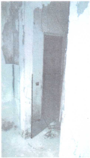
Значне ураження стін та стелі грибковими захворюваннями
