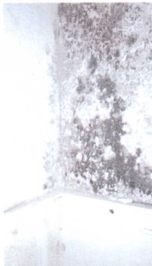
Значне ураження стін та стелі грибковими захворюваннями
