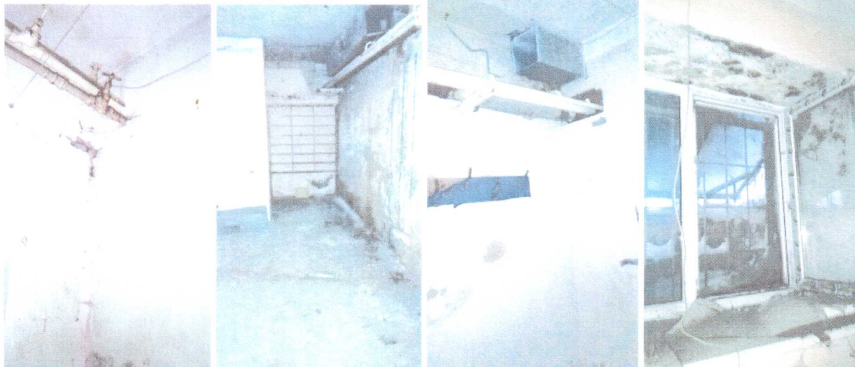
Значне ураження стін та стелі грибковими захворюваннями
