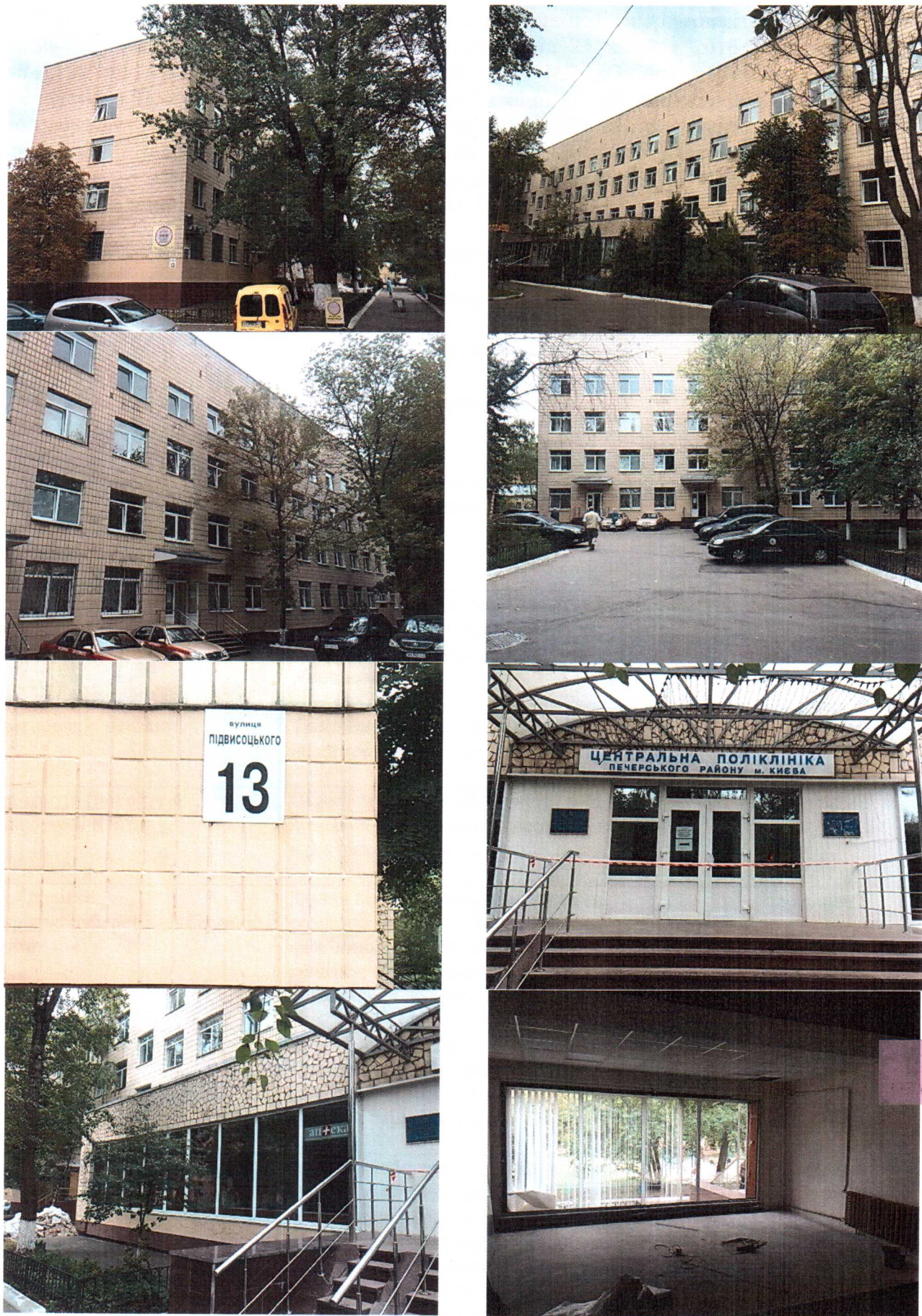
Види 1-8. Будівля КНП «Консультативно-діагностичний центр» Печерського району м. Києва та частина приміщення, що підлягає оцінці за адресою: м. Київ, вул. Підвисоцького, 13
